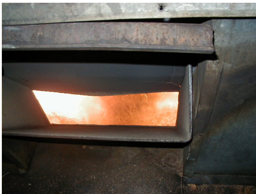
Figur 6 Bild på luckan genom vilken en av kamerorna monterades.
