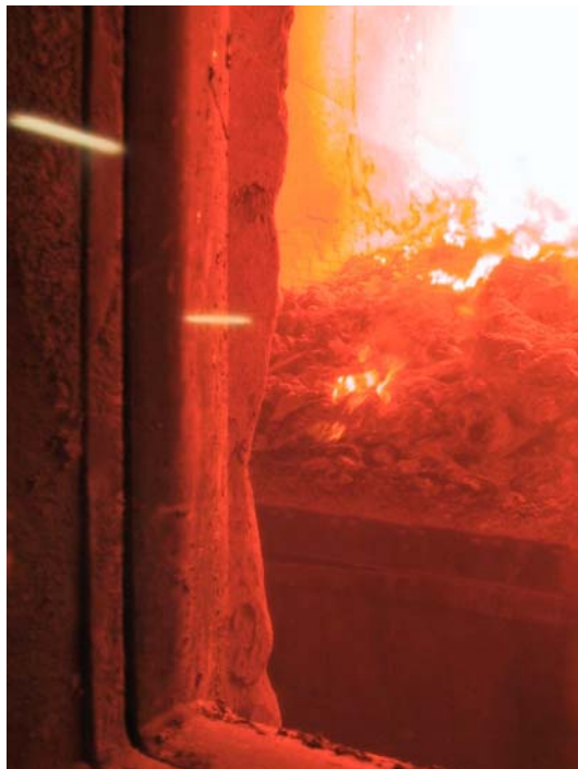
Figur 7: Förbränningsrum sett från mätplatsen.
