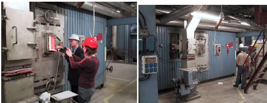
Figur 8: Placering av mätinstrument och sidovägg av pannan.
